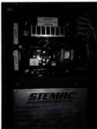
Conferido reaperto nas conexões do regulador de tensão.
