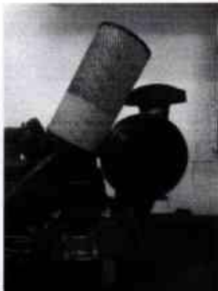
Inspeção no filtro de ar e limpeza no compartimento.
