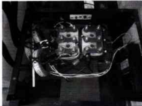
Conferido reaperto nas conexões da baseta/gerador.
