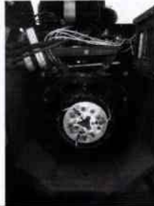
Inspeção nas conexões dos diodos do gerador.
