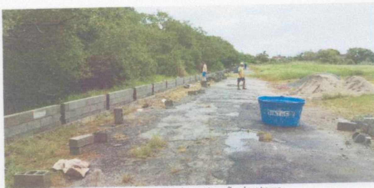
FOTO 02: Mureta de contenção do aterro.
