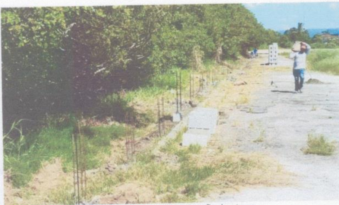
FOTO 01: Mureta de contenção do aterro.
