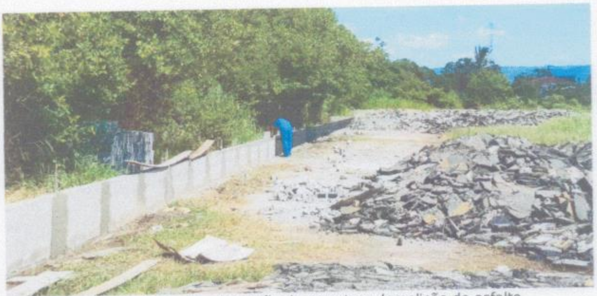
FOTO 04: Impermeabilização da mureta e demolição do asfalto.
