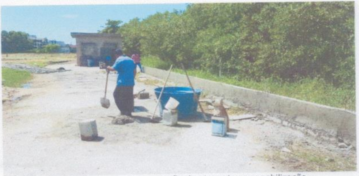
FOTO 03: Mureta de contenção do aterro impermeabilização.
